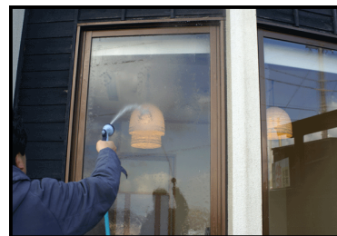
写真：光触媒施工の窓ガラスへの散水の中の様子(均一な水の膜ができて簡単に洗浄ができます)
